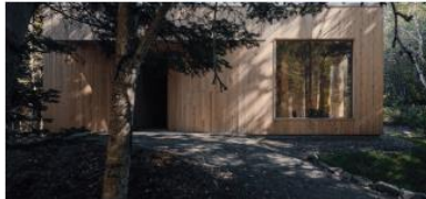
Plantation intensive et conservation d'arbres feuillus, de conifères et d'arbustes agissant comme filtre d'intimité aux abords et au cœur du site.
